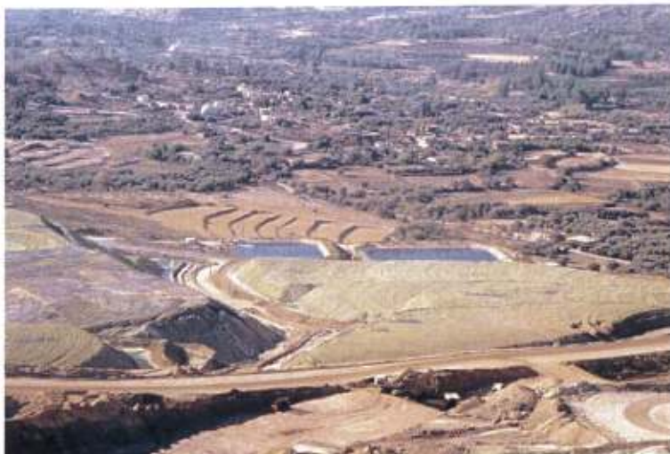
Φωτ.4.: Σωρός εκχύλισης μεταλλεύματος και δεξαμενές χαλκούχου διαλύματος
