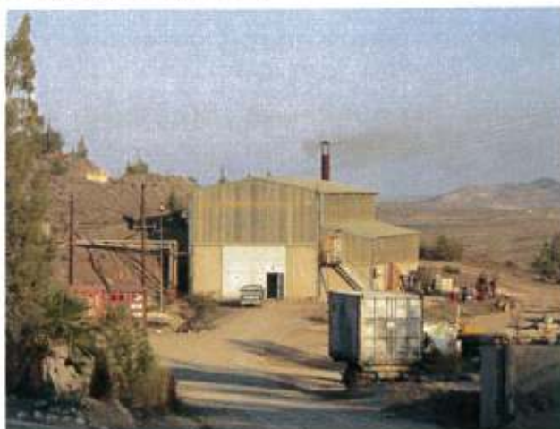
Φωτ.5.: Ηλεκτροπαραγωγός σταθμός
