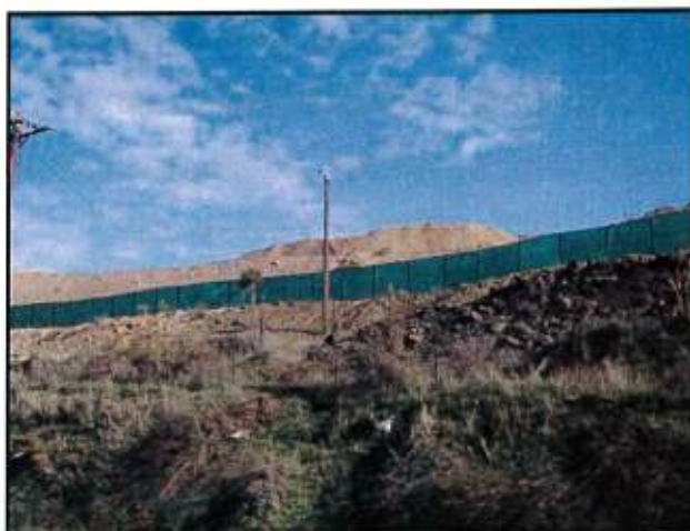
Φωτ.7.: Ανεμοθραύστης από πλαστικό δίχτυ για τον περιορισμό της σκόνης από την κίνηση των βαρέων οχημάτων
