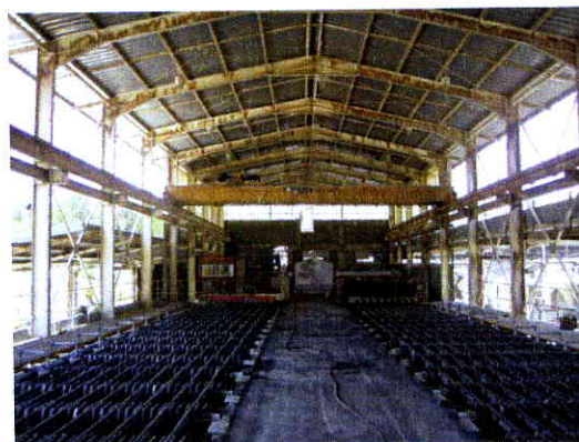
Εικ.5. Εργοστάσιο Ηλεκτρόλυσης
