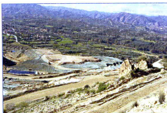
Εικ.13. Σταδιακή κάλυψη σωρού με αδρανή υλικά
