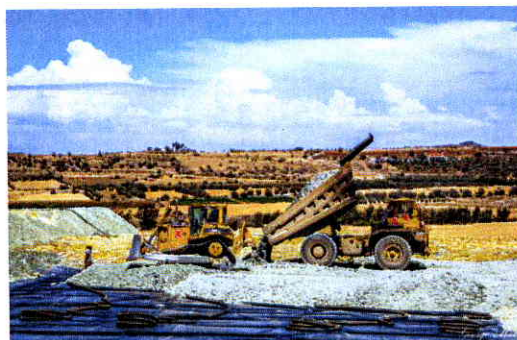
Εικ 4. Κατασκευή σωρού εκχύλισης
