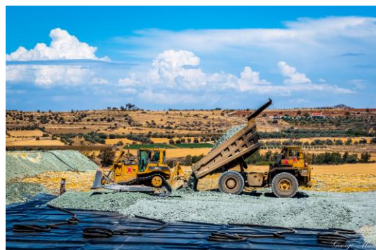
Εικ 4. Κατασκευή σωρού εκχύλισης
